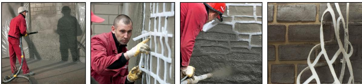
*Bilder 1-4: Arbeitsschritte zur Herstellung der Reliefoberfläche im Spritzbeton*
