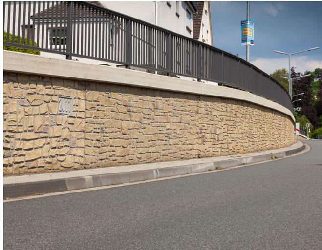
*Bild 11: Trägerpfahlwand mit Spritzbetonoberfläche*
