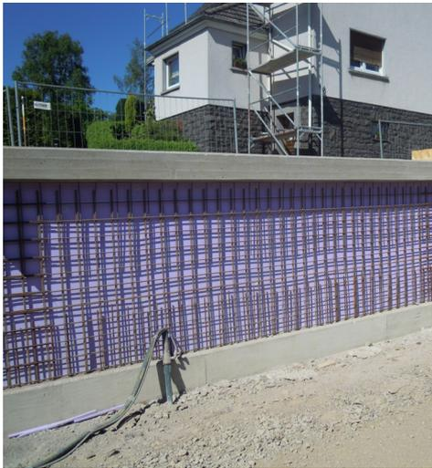
*Bild 10: Trägerpfahlwand vor der Spritzbetonausfachung*
