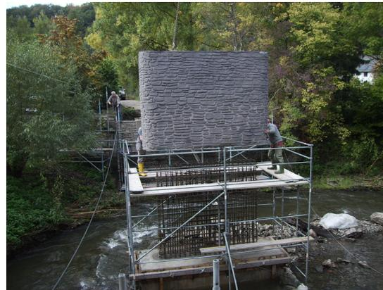
*Bild 7: Vorfertigung der Pfeilerhülle aus bewehrtem Spritzbeton,  $d = 8$  cm mit Reliefbetonoberfläche*
