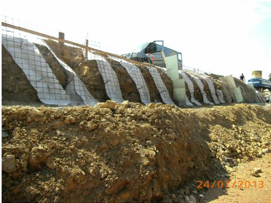
*Bild 12: Ungesicherte Steilböschung*
