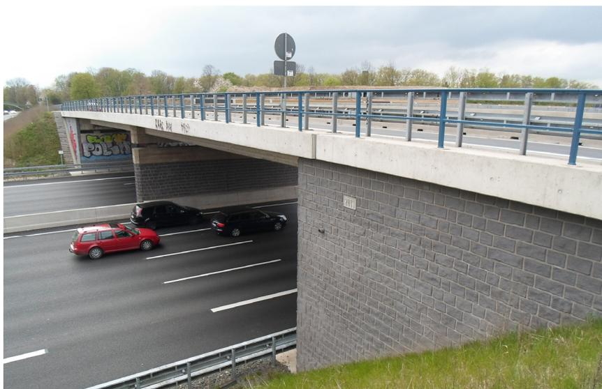
*Bild 6: Reliefoberfläche der Brückenunterbauten aus Spritzbeton*
