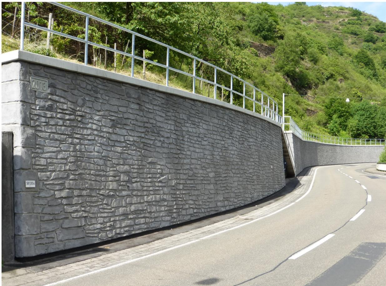
*Bild 23: Ertüchtigte Stahlbetonstützmauer mit Spritzbetonoberfläche in Natursteinoptik*
