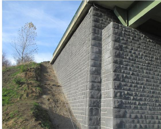
*Bild 20: Brücke Neukieritzsch, WL West nach der Verstärkung und Instandsetzung mit Spritzbetonoberfläche in Mauerwerksoptik*
