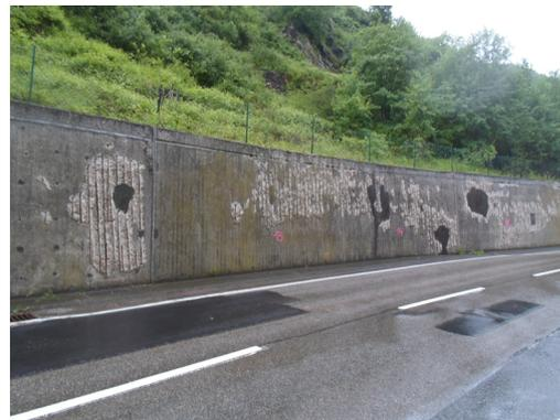
*Bilder 21 und 22: Betonschäden an der Stahlbetonstützmauer*
