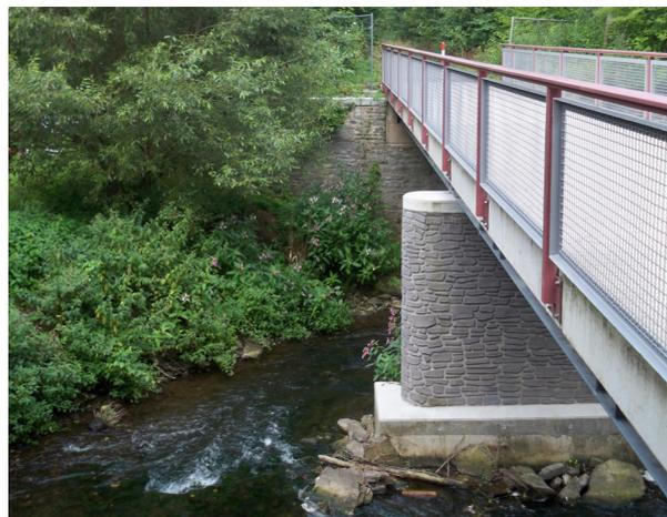
*Bild 9: Brücke Dorsel nach dem Ausbetonieren der Pfeilerhülle aus Spritzbeton in Steinoptik*
