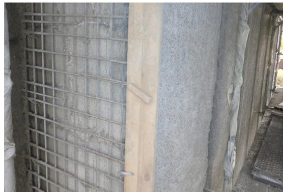
*Bild 15: Freilegen von Betonschadstellen*    *Bild 16: Ertüchtigung der Widerlager mit bewehrtem Spritzbeton,  $d = 10\text{ cm}$*
