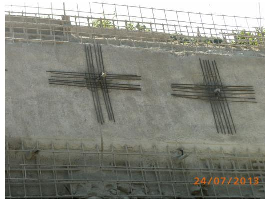
*Bild 13: Spaltzugbewehrung im Bereich der Ankerköpfe*
