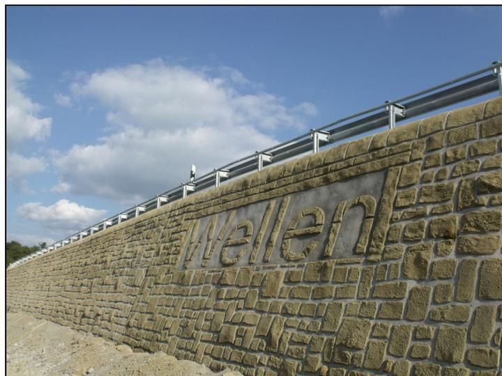
*Bild 14: Rückverankerte Böschungssicherung aus Spritzbeton in Natursteinoptik*
